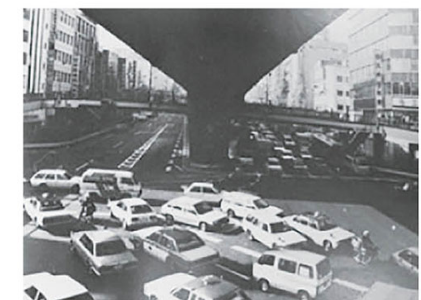
南口交差点の国道246号線と 首都高速3号線
