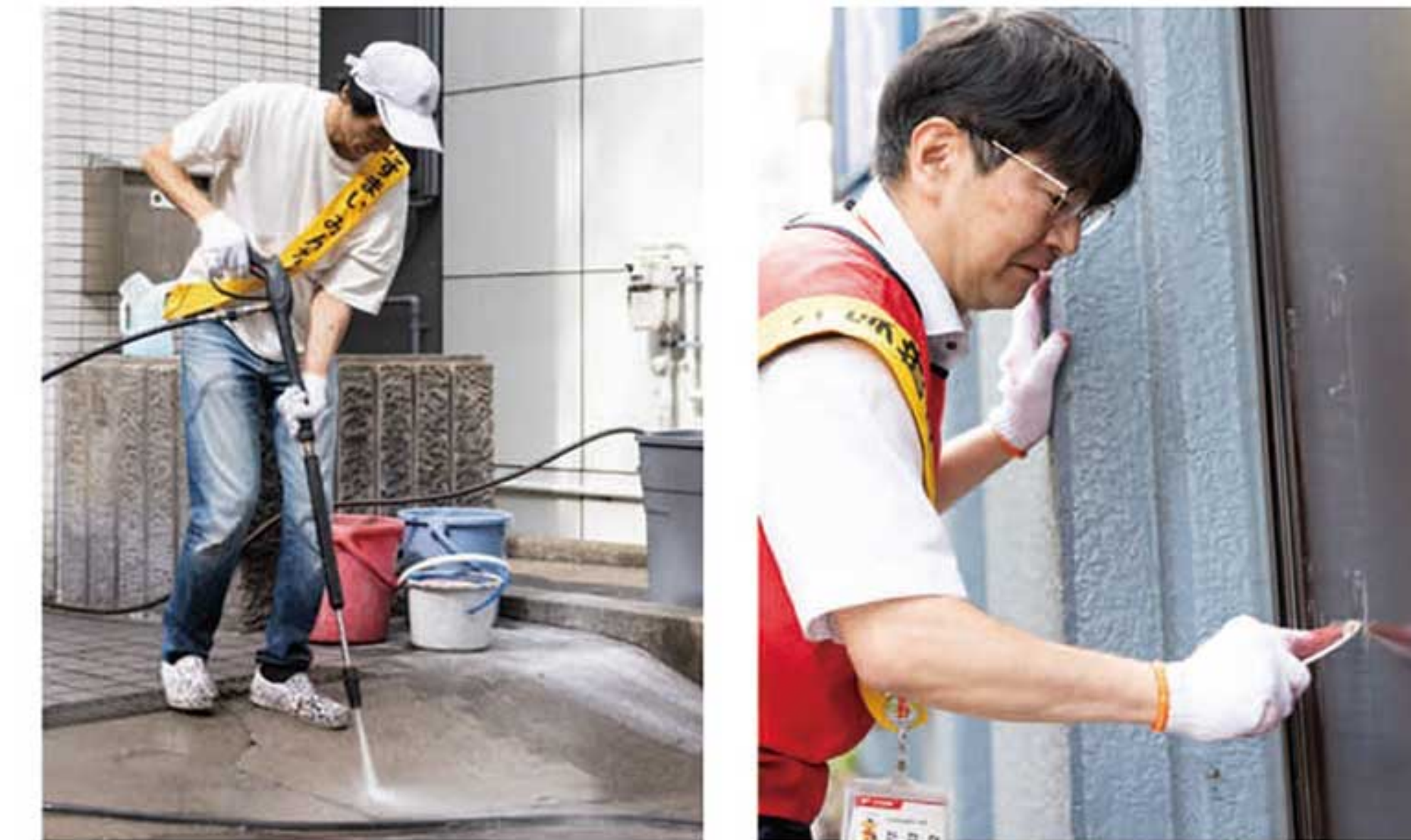
高圧洗浄で清掃
