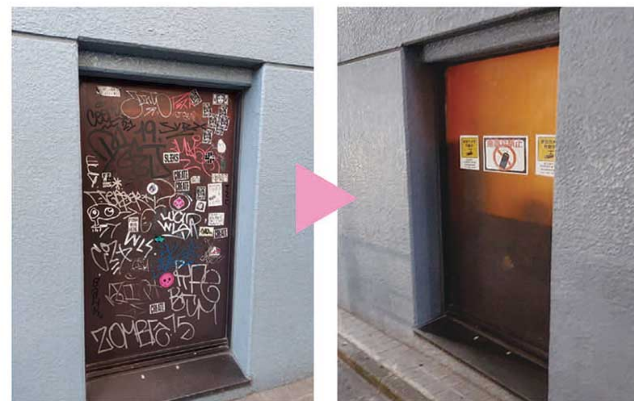
落書きを消して綺麗になった壁面
